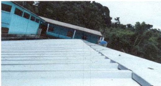
Foto 5: Sustitución de capote de lámina
