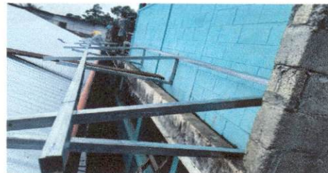
Foto 6: Cambio de lámina, reparación de captación y bajada de agua fluvial con tubo pvc "3"
