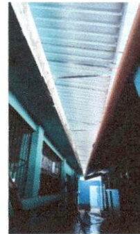
Foto 4: reparación de captación y bajada de agua fluvial con tubo pvc "3".
